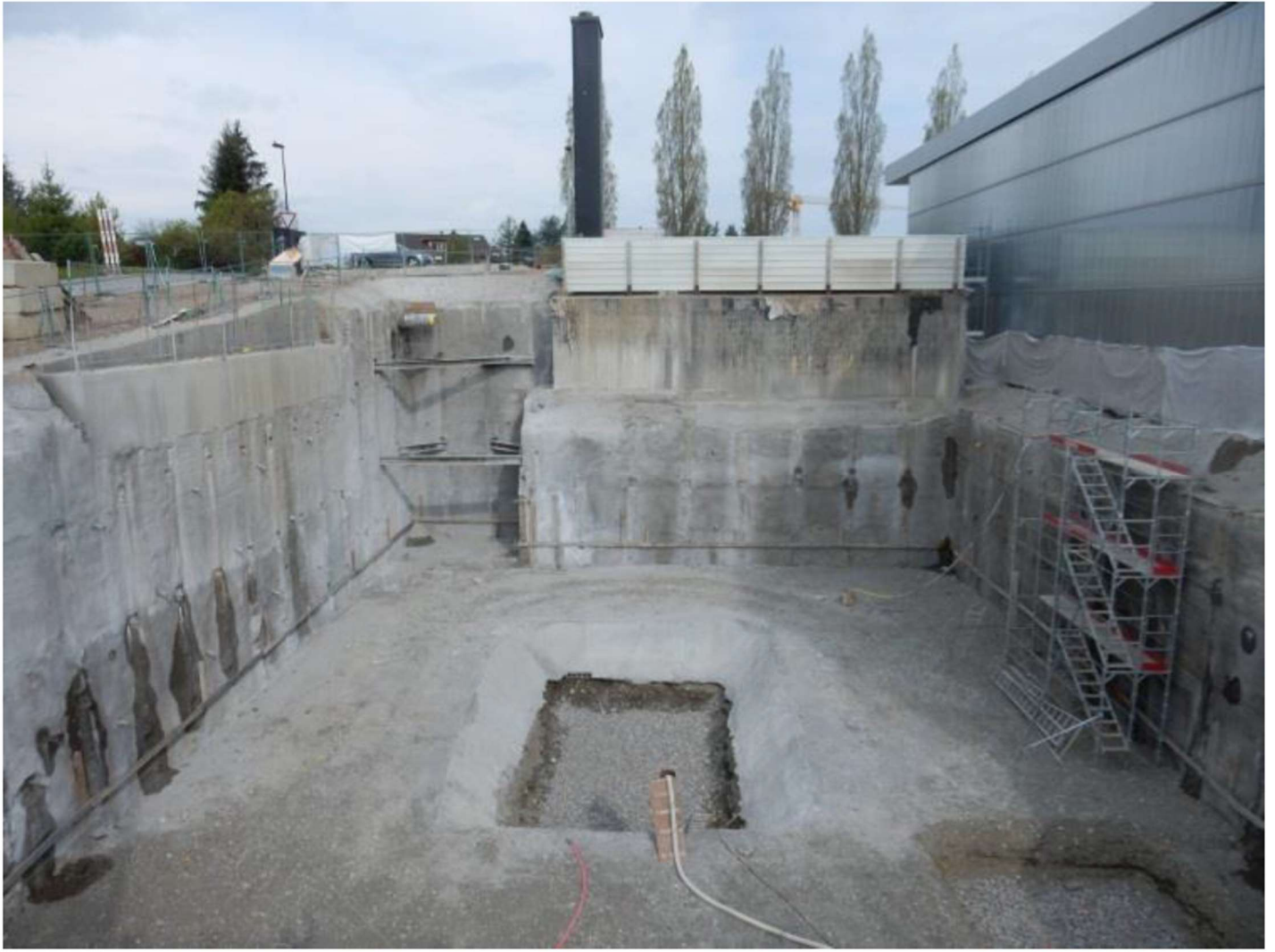
Figure 2 : Vue de l'enceinte de fouille
