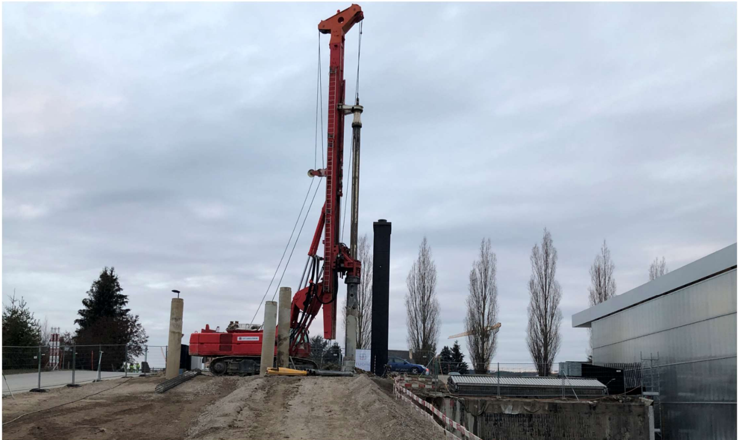
Figure 1 : Vue de l'exécution des pieux de de la paroi Lutécienne (Foreuse R825)
