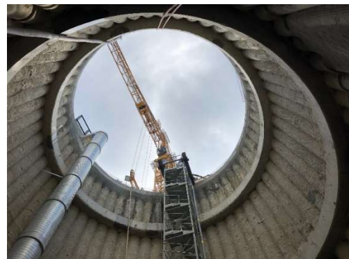
Puits de la Brouette – 60 pieux sécants de profondeur 30 à 50m
