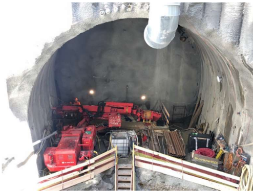
Rameau du puits de la Brouette – Sondage de reconnaissance de 200m au carottier à câble
