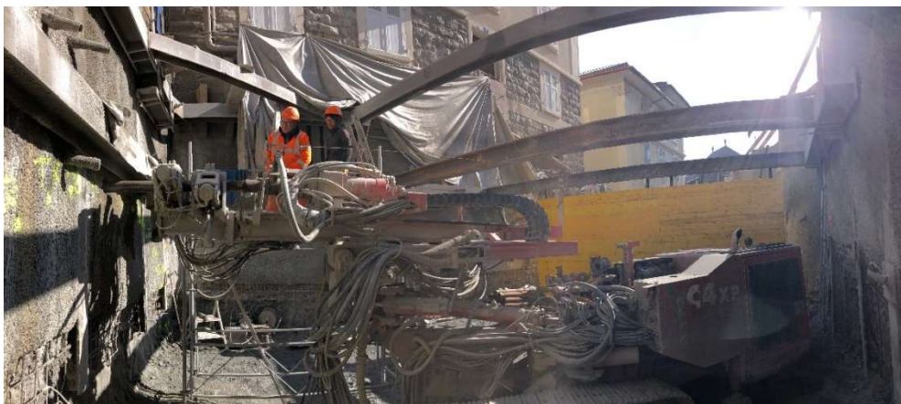
Issue de secours Mathias Mayor – Forage de la voûte parapluie
