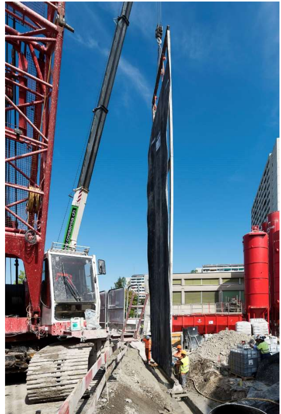
Levage du cadre avec membrane PEHD
