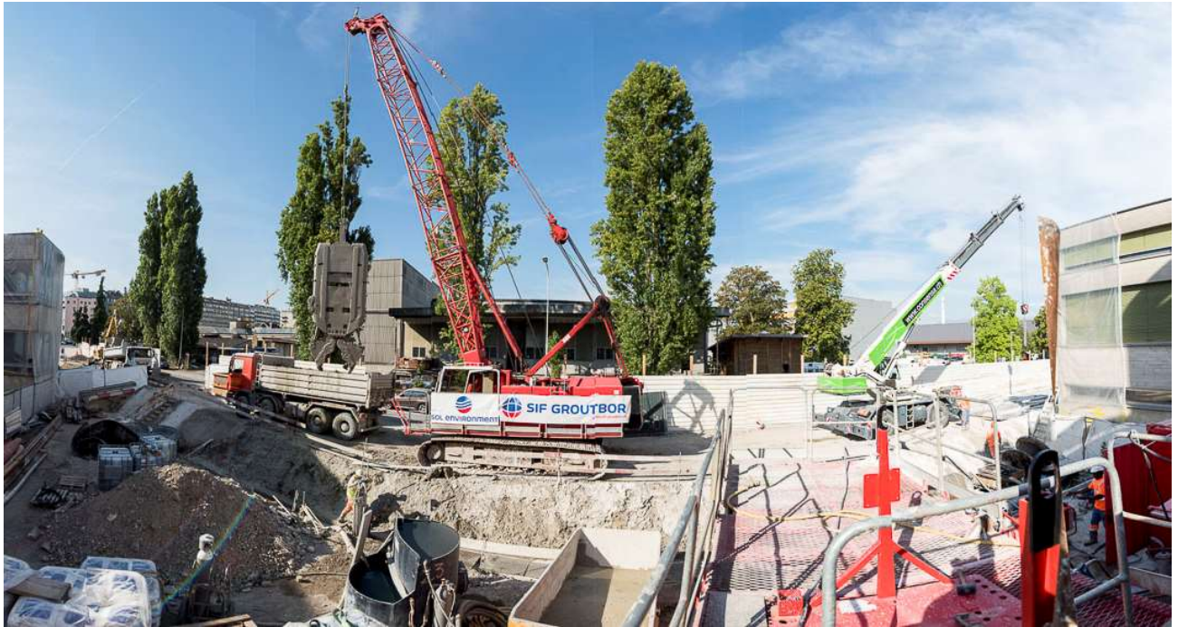
Un atelier en excavation (à gauche) et un deuxième à la préparation de la membrane PEHD sur le cadre métallique (à droite).
